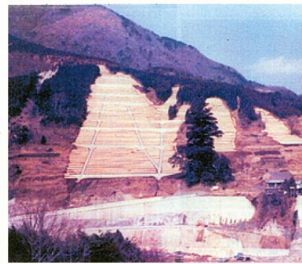
○山腹工施工状況（昭和49年）
