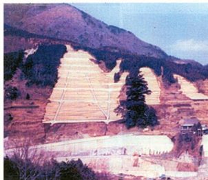
○山腹工施工状況（昭和49年）
